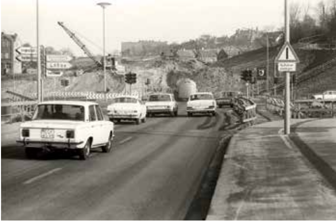
Blick von der Schwentinebrücke auf die Baustelle für die K31 in Richtung Laboe zur Fertigstellung des »Kieler Hufeisens«, März 1969, StAK 44443, Fotograf Friedrich Magnussen
