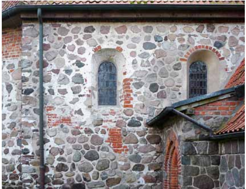
5 Ratekau, Altarhaus der Kirche von Norden vor der Sanierung von 2009, zahlreiche historische Oberflächen aus mehreren Jahrhunderten (Aufn. 2007)
