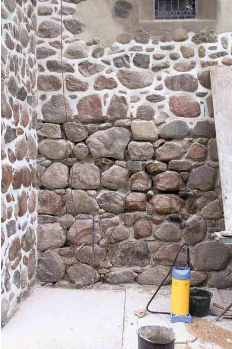
4 Ratekau, Südfassade des Chores der Kirche, untere Mauerhälfte entfugt, vorbereitet zur vollständigen Neuverfugung (Aufn. 20. Juli 2009)
