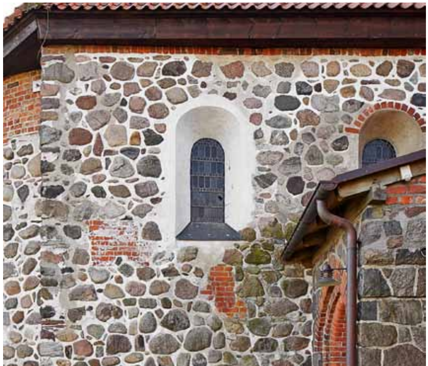
6 Ratekau, Altarhaus der Kirche von Norden nach der Sanierung von 2009, historische Ver fugungen weitgehend durch neue Ver fugung ersetzt (Aufn. 2014)
